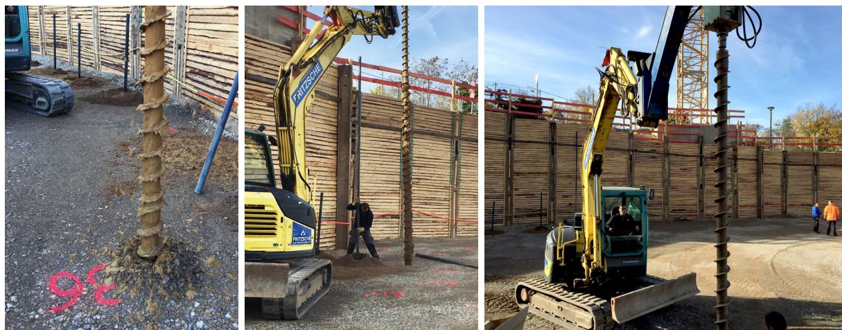
Bevor eine Sicherheitsdetektion durchgeführt werden kann, muss eine Bohrung und ein Kunststoffrohr eingebracht werden, durch welches später bei der Bohrlochdetektion die geomagnetische Sonde geführt werden kann.
